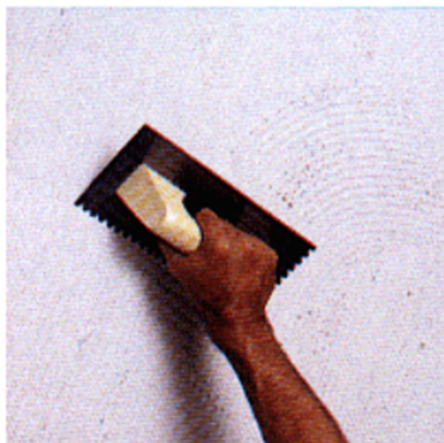
Espalhamento da argamassa de assentamento.
