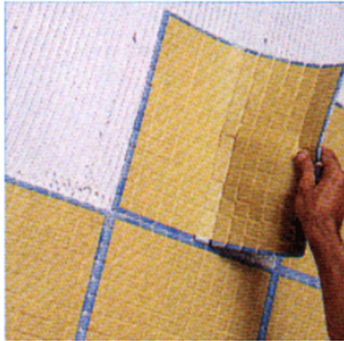
Colocação das placas com as pastilhas.
