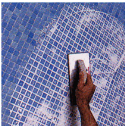
Aplicação da pasta de rejuntamento.
